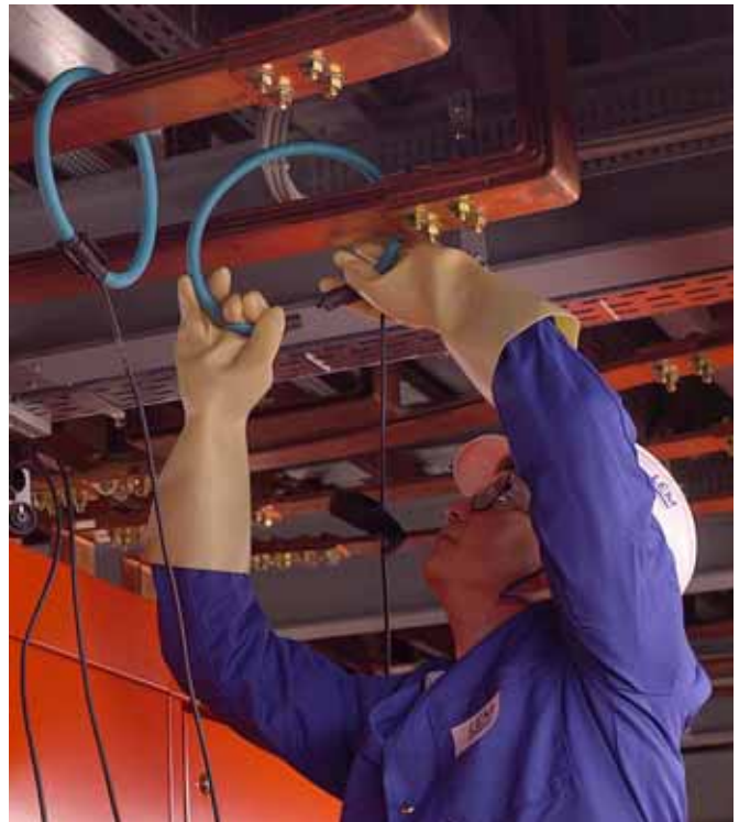
Figure 40: LEM-flex enroulé autour d'un ou de plusieurs conducteurs.
